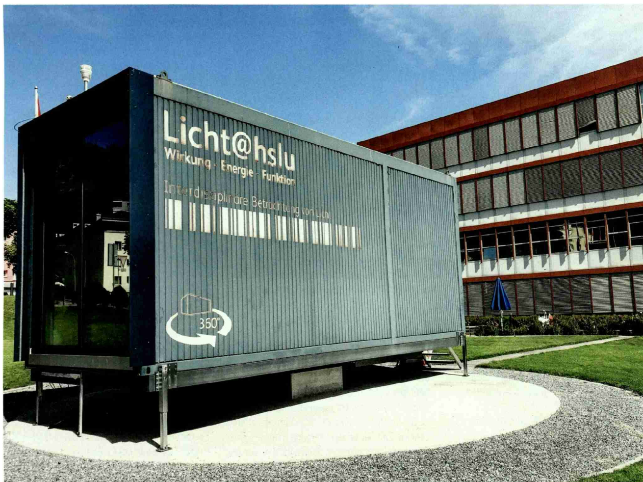
Der drehbare Lichtmesscontainer auf dem Campus der Hochschule Luzern in Horw verfügt über einen grossen Lichteinlass an der Stirnseite.
