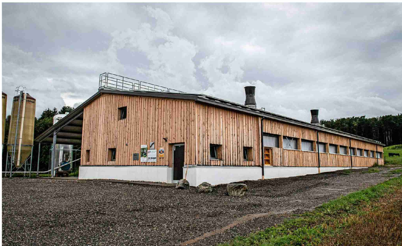
Auf dem Dach eine Solaranlage, dick isoliert, innen mit Erd- und Abwärme geheizt: Die neue Halle soll Energie sparen. Fotos: Marcel Bieri
