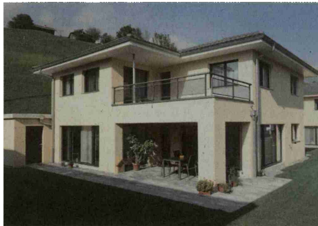
Zeitgemässe Architektur: Die Häuser versprechen hohen Wohnkomfort
