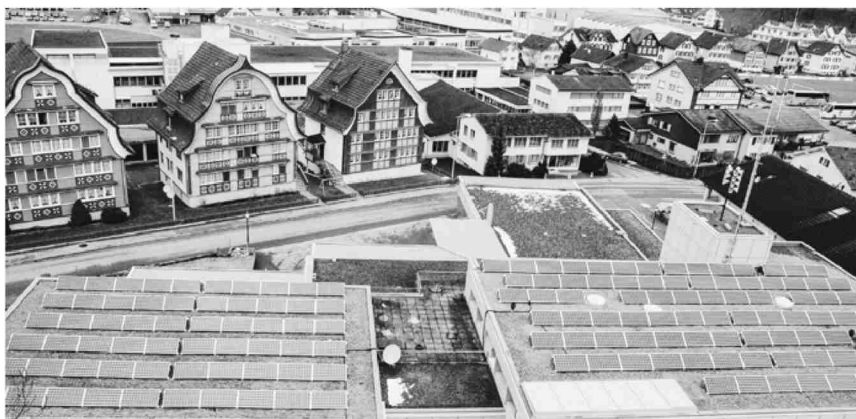
Die Photovoltaik-Anlage auf der Feuerschaugemeinde steht symbolisch für den Wandel bei der Energiegewinnung in Innerrhoden. (Bild: Archiv AV)
