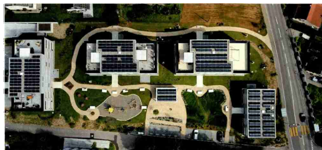
Die PEH-MFH sind U-förmig auf dem Grundstück platziert. Die auf den Fischköchern aufgestellten Solarmodule haben Ausrichtung Ost/West. (Bild: Setz Architektur)
