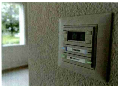
Klein aber oho: Gerät für Einstellung Raumtemperatur, Visualisierung Stromtarif und Bedienung solaroptimierte Haushaltgeräte. (Bild: Smart Energy Control AG)
