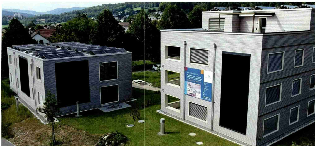
Teile der Süd-, Ost- und Westfassaden sind mit modernen Photovoltaik-Panels bestückt. Auf dem Dach sind die Module Ost/West-ausgerichtet. (Bild: Setz Architektur) kühlen. Gleichzeitig bewirkt dies eine Regeneration der Erdwärmesonden.
