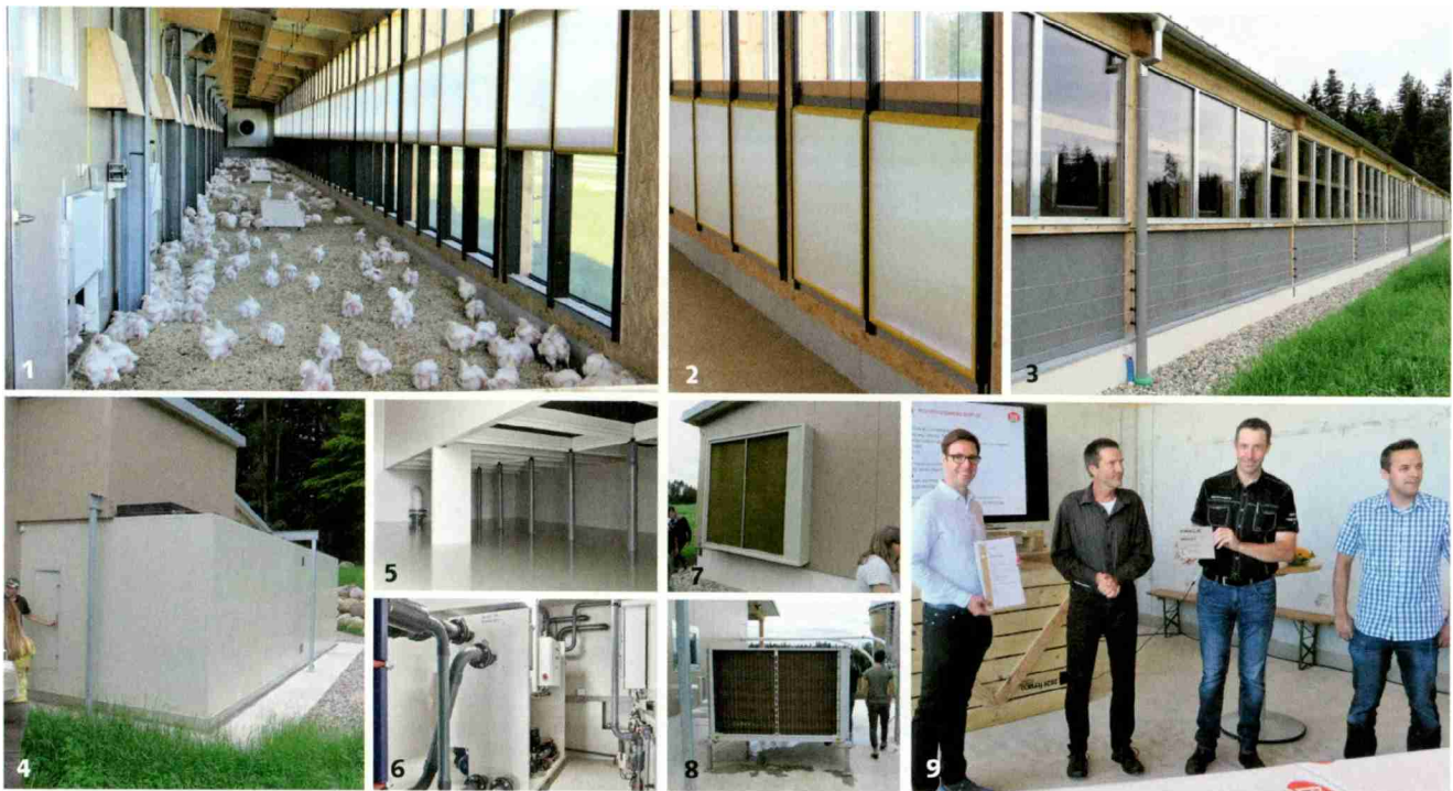
Bilder: Der Wintergarten geöffnet (1), mit geschlossenen Schiebern (2) und von aussen (3, unten mit Windschutznetz). 4: Der Anbau für Luftwäscher (5) und Wärmerückgewinnung (6). 7: Der Wärmetauscher für die Wintergarten-Zuluft (in Bild 1 ganz hinten: Lufteintritt und Ventilator). 8: Die Wärmepumpe für die Heizenergie. 9: von links: Projektleiter Stefan Werren (Bell), Bruno Hari (Minergie Schweiz) und die beiden Stalleigentümer Samuel Guggisberg und Heinz Nussbaum bei der Zertifikats-Übergabe. → Bild des Stalles von aussen siehe Titelseite.
