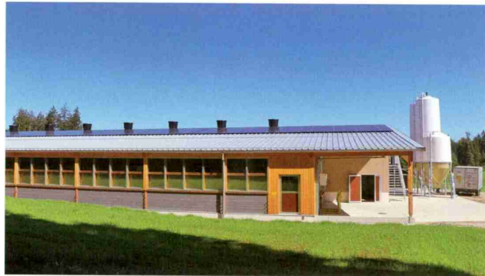
Die Photovoltaikanlage auf dem Dach führt zu einem Energieüberschuss, der auf dem Betrieb genutzt wird.
