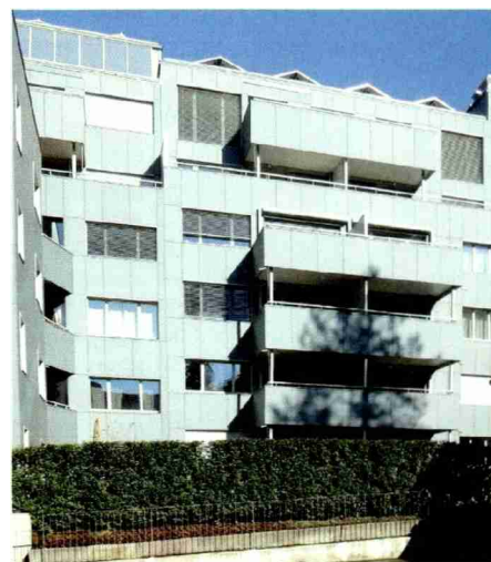
Beim sanierten und aufgestockten Mehrfamilienhaus an der Hofwiesen-/Rothstrasse gehört die Komfortlüftung zum Plusenergie-Gesamtkonzept.
