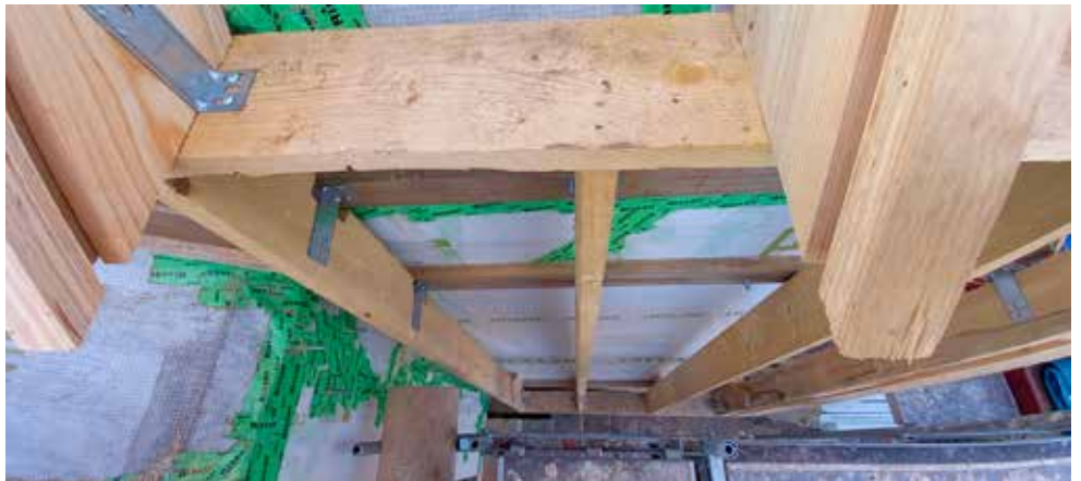
Vue de l'ossature rapportée en façade avant la pose de la fibre de bois et l'insufflation de ouate de cellulose. On voit bien les équerres réglables permettant de rattrapper la planéité de la façade.
