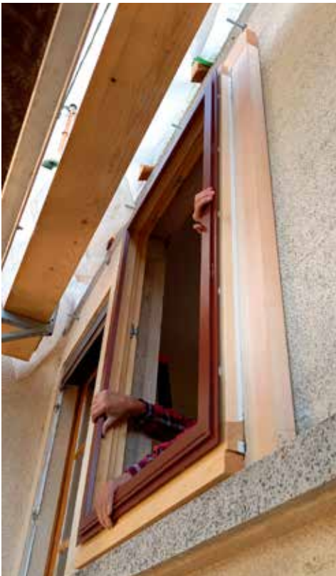
Dans le même temps, les menuiseries triple vitrage de Bader sont posées en tunnel, de façon à isoler également leurs dormants.
