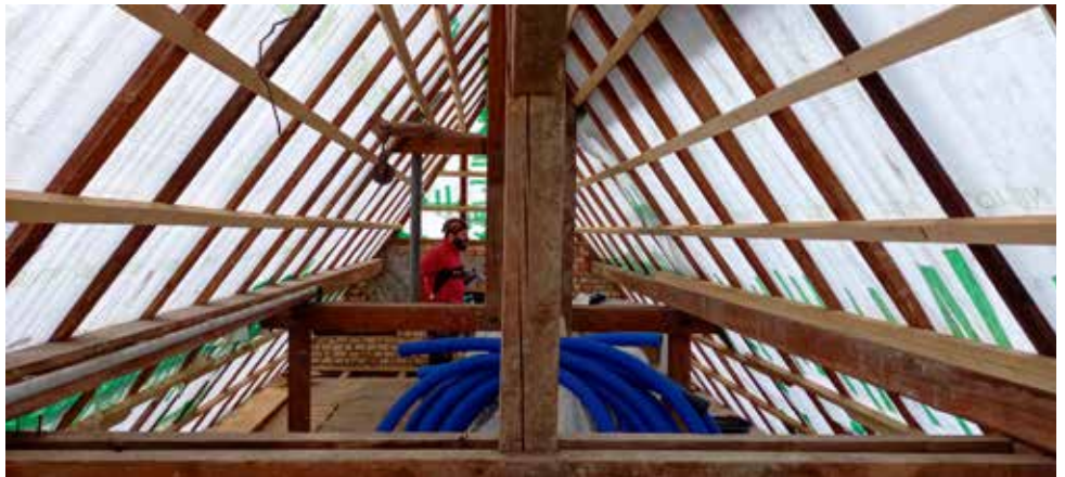
La surélévation isolée de la toiture libère un nouvel espace de rangement sous les combles.
