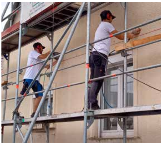
Les enduits existants sont percés pour fixer les chevilles qui porteront l'ossature bois de l'isolation par l'extérieur. Cette dernière descend sous le niveau du rez-de-chaussée.
