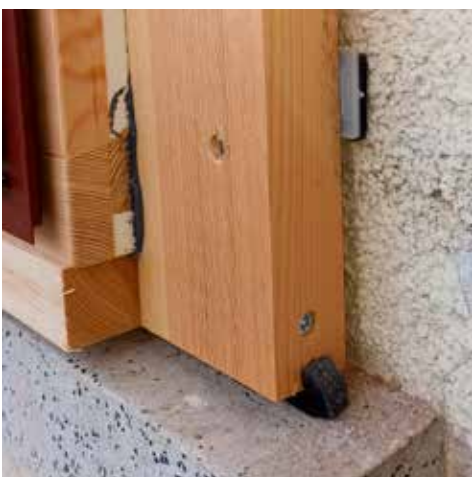
Dans le même temps, les menuiseries triple vitrage de Bader sont posées en tunnel, de façon à isoler également leurs dormants.
