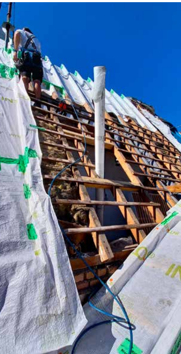
La toiture existante est recouverte du frein-vapeur hygrovariable avant sa surélévation en poutres en I de 30 cm. Le débord de toiture est également rallongé.
