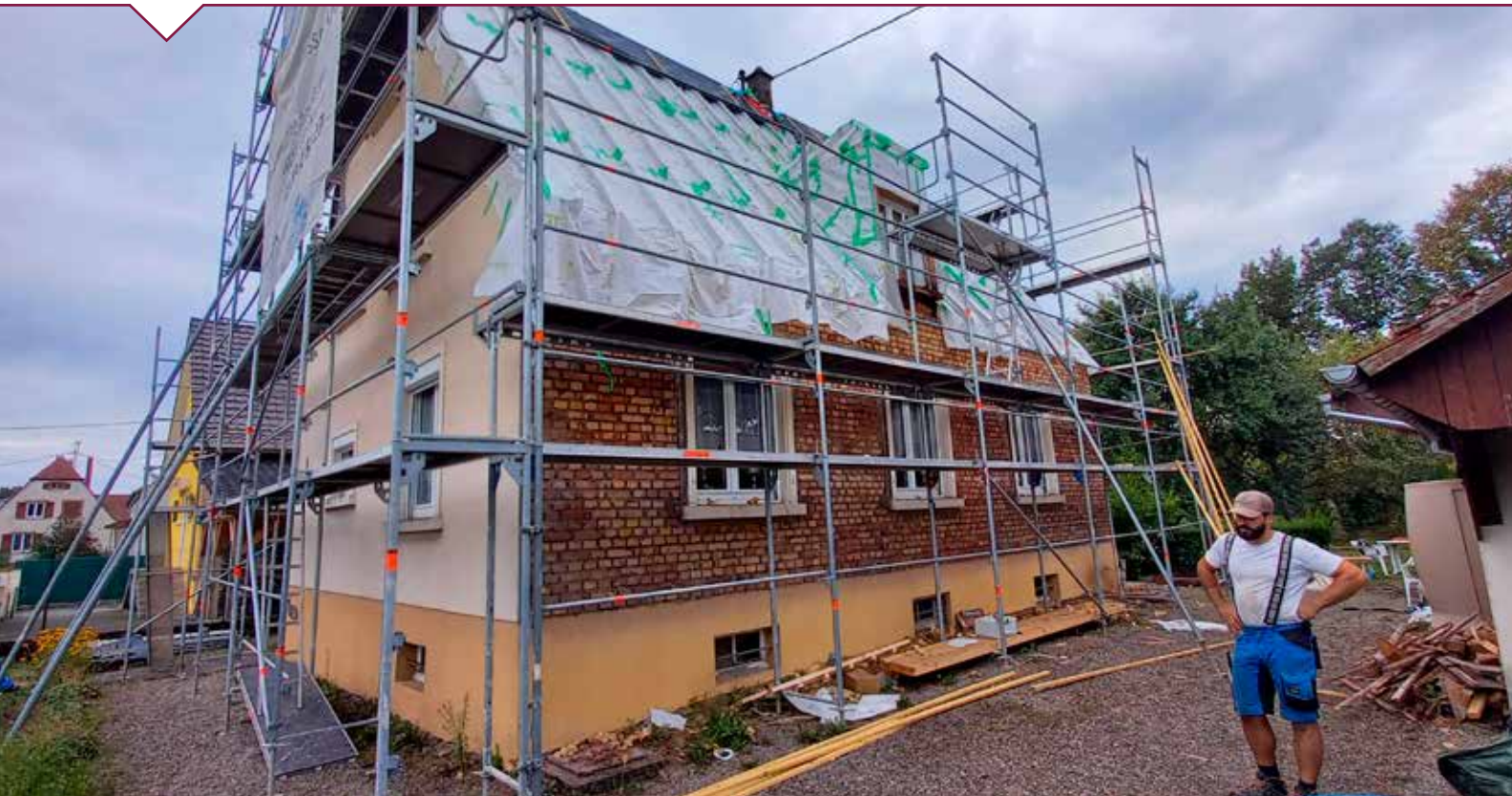
La toiture existante est recouverte du frein-vapeur hygrovariable avant sa surélévation en poutres en I de 30 cm. Le débord de toiture est également rallongé.
