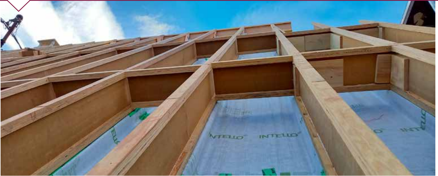
Les poutres I de la nouvelle charpente sont posées sur le frein-vapeur Intello. La pose d'un pare-pluie permettra d'y insuffler la ouate de cellulose.
