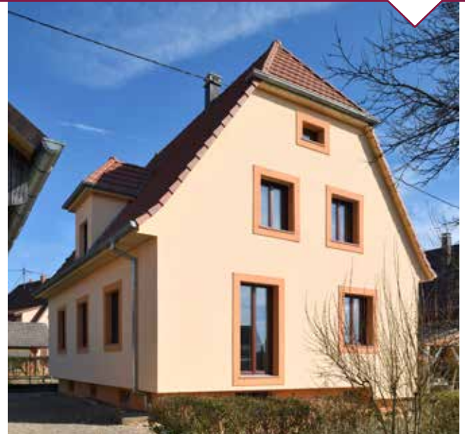
Après travaux, des consommations estimées à 116 € pour le chauffage.
