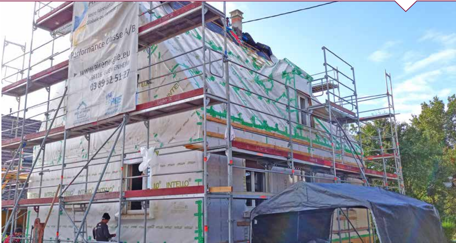
La membrane est soigneusement posée jusqu'en bas, formant une barrière continue pour l'étanchéité à l'air. On aperçoit les murailles où viendront se fixer les équerres réglables de l'ossature.
