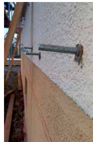
Les enduits existants sont percés pour fixer les chevilles qui porteront l'ossature bois de l'isolation par l'extérieur. Cette dernière descend sous le niveau du rez-de-chaussée.
