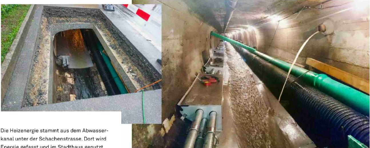
Die Heizenergie stammt aus dem Abwasserkanal unter der Schachenstrasse. Dort wird Energie gefasst und im Stadthaus genutzt.
