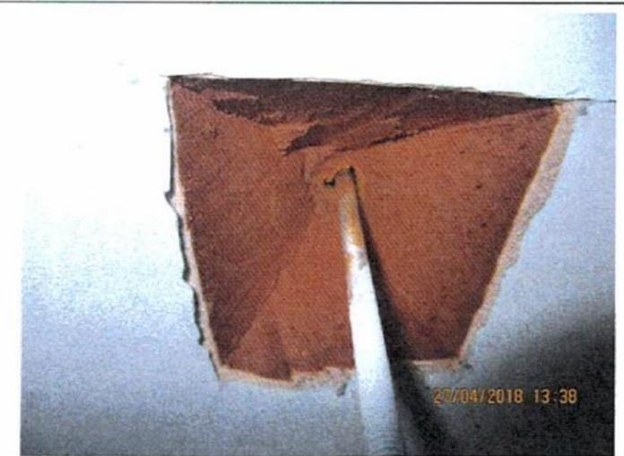
d) Ouverture de l'isolation intérieure pour inspection de l'éventuelle corrosion des fixations
