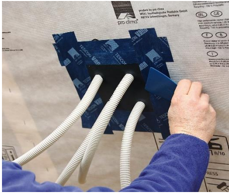
Illustration 11 : Manchette appropriée pour gaines multiples (source : image gauche : pro clima Suisse GmbH, image droite : Kel-DPU)
