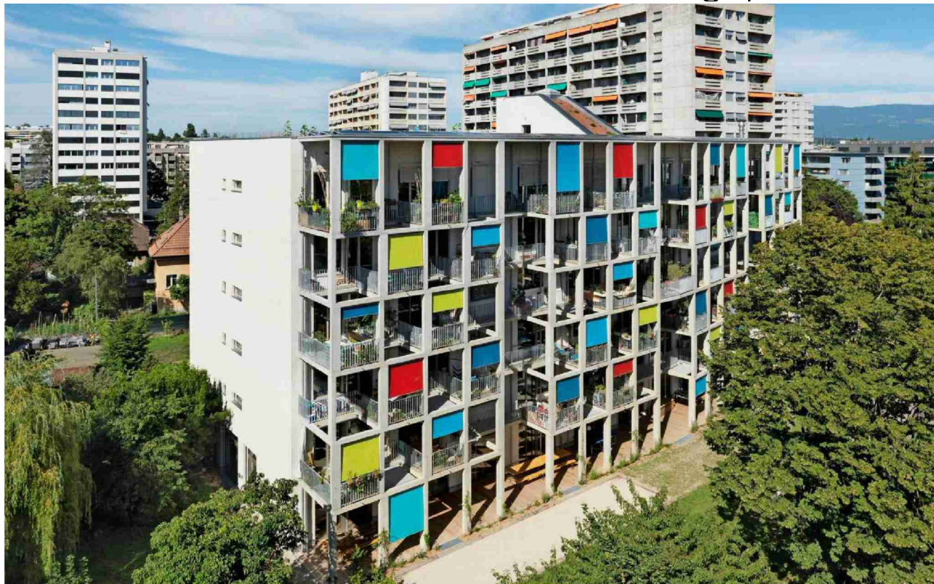
Les édifices qui respectent les recommandations de l'association eco-bau sont toujours plus nombreux en Suisse. À l'exemple de ce bâtiment érigé à la rue Soubeyran, à Genève, dont on voit la façade sud qui profite au mieux toute l'année de la réalité climatique du lieu. ATBA ARCHITECTURE • ÉNERGIE/ANNIK WETTE
