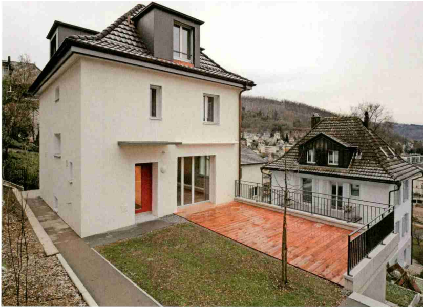
En décembre 2017, le premier certificat Minergie «System Renewal» a été attribué à ce bâtiment à Ennetbaden (AG).
