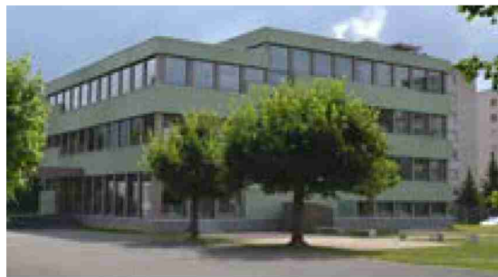
L'extension du Collège de Delémont est labellisée Minergie.
