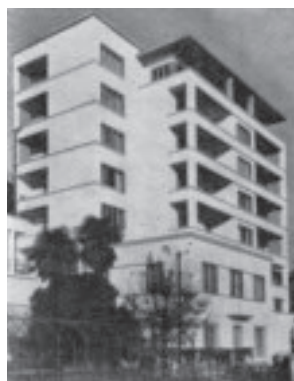
Wohnhaus «Pax» Lugano, 1934 Architekt: Augusto Guidini
