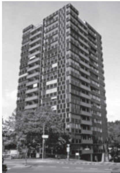
Realisiertes Beispiel Prinzip 1: 2000 Watt-Sanierung Hochhaus Sihlweid, Zürich Fensterintegrierte Lüftungselemente mit Wärmerückgewinnung (WRG)
