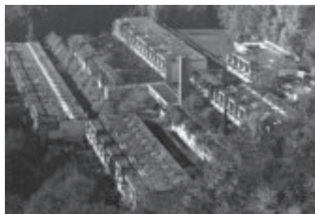
Quartier de Halen Herrenschwanden Architectes: Atelier 5 1955-1961
