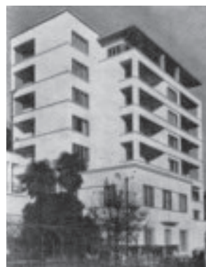
Immeuble d'habitation «Pax» Lugano Architecte: Augusto Guidini 1934
