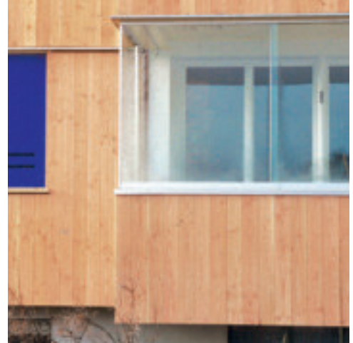
Rénovation d'un immeuble d'habitation à Konolfingen/BE: transformation des balcons en vérandas, avec ouvertures décentralisées pour l'apport d'air neuf
