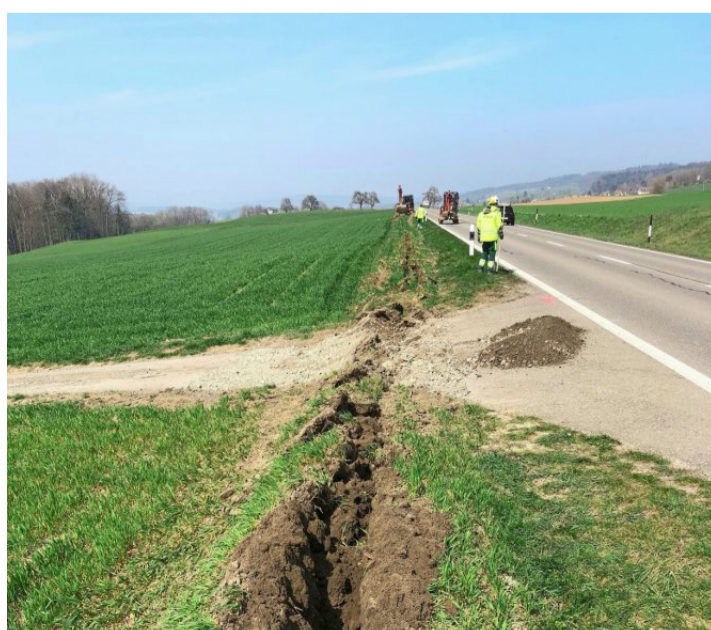
Zwischen Bellikon und Remetschwil werden die Rohre im Bereich des heutigen Radwegs eingepflügt.
