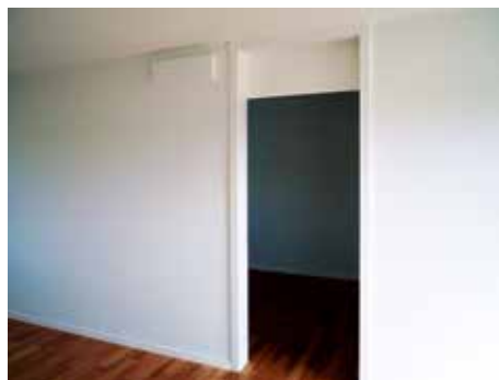
Il compensatore attivo convoglia l'aria dal soggiorno alla camera da letto.
