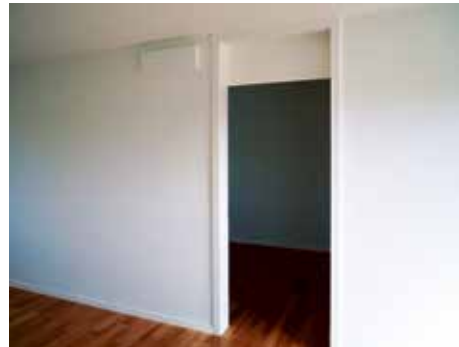
Le ventilateur mixte transporte l'air de la chambre à coucher dans le séjour.
