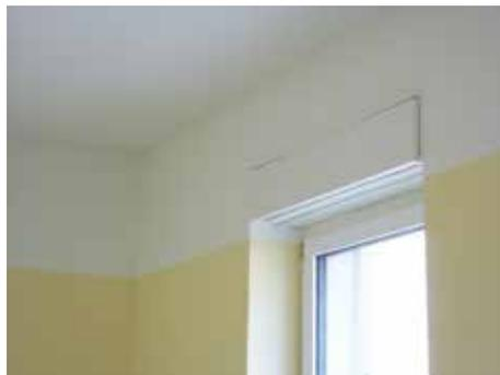
Le unità di ventilazione per singolo locale sono state facilmente inserite negli allargamenti del telaio delle finestre.
