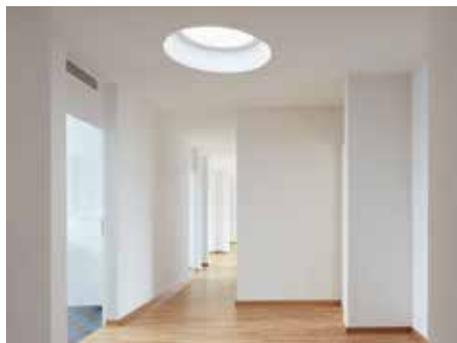
L'aria è immessa nel corridoio tramite la griglia posta sopra la porta del bagno. Con il sistema convenzionale di circolazione dell'aria, sarebbe stato necessario un controsoffitto, che avrebbe coperto il lucernario.
