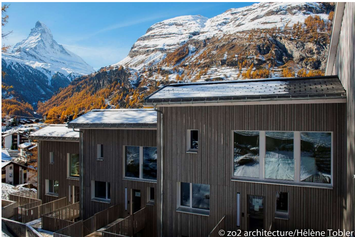
Légende : projet de rénovation « Résidence Legendär by REKA » à Zermatt
