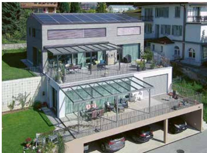
Grâce à la protection solaire, qui est contrôlée par un système de gestion de l'énergie, le bâtiment présente également des températures ambiantes agréables en été.
