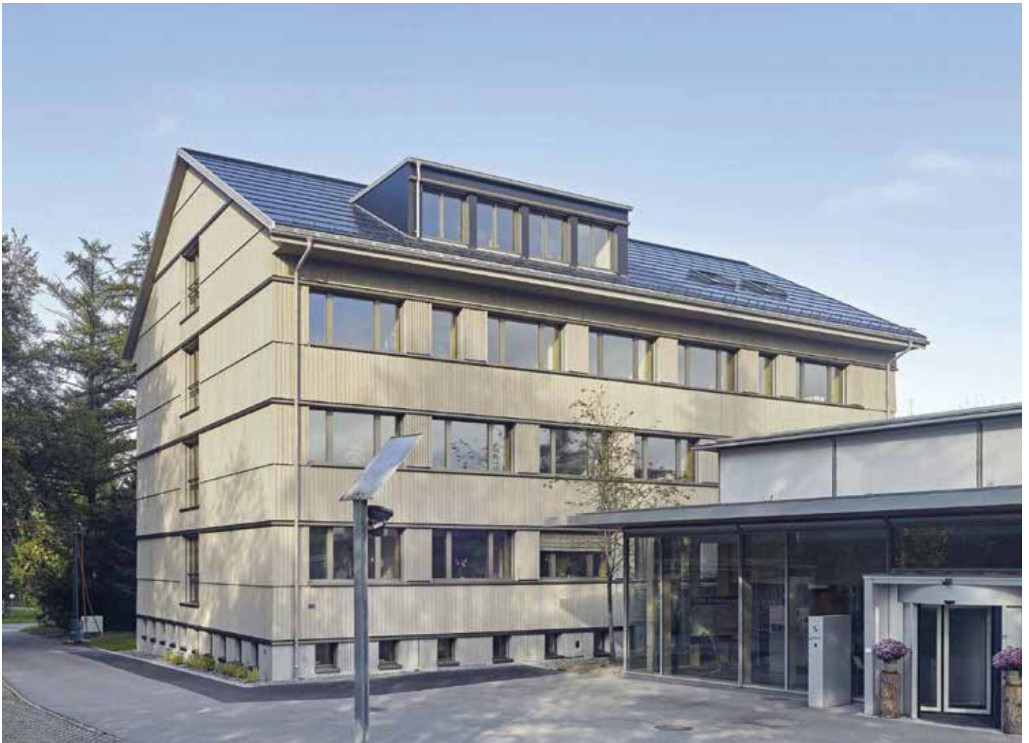
L'edificio dell'Istituto federale di ricerca per la foresta, la neve e il paesaggio (WSL) certificato Minergie-A-ECO è dotato di un impianto fotovoltaico di 750 m 2 .
