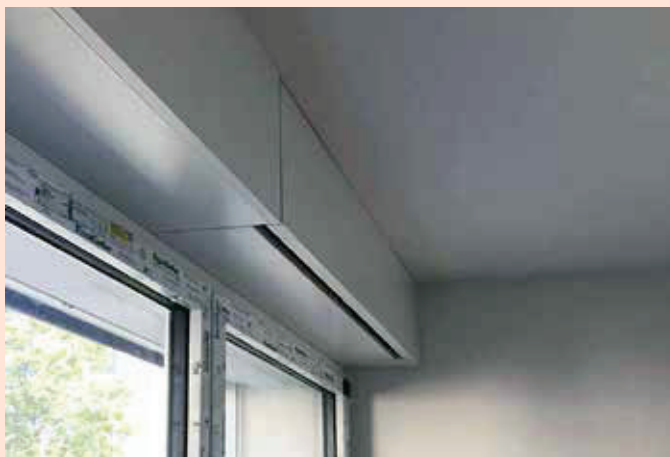
Figure 3.16: Appareils VPL intégrés dans l'élargissement des cadres de fenêtres, sans complication particulière. (Source: Ventoswiss AG)
