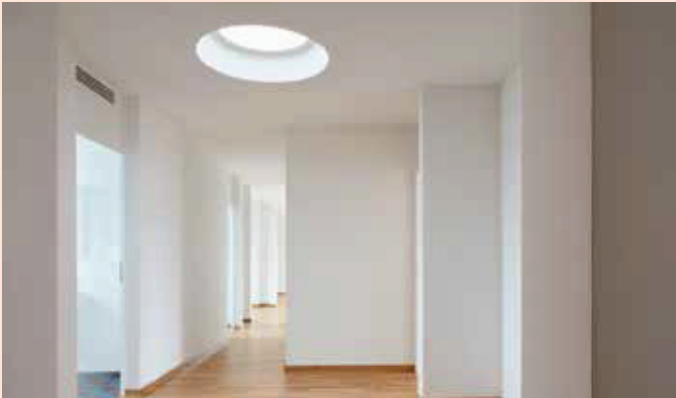
Figure 3.11: Par la bouche d'air disposée au-dessus de la porte de la salle de bain (à gauche), l'air fourni parvient dans le couloir. Une circulation conventionnelle de l'air aurait impliqué un faux-plafond recouvrant la lumière zénithale. (Source: Ralph Feiner)
