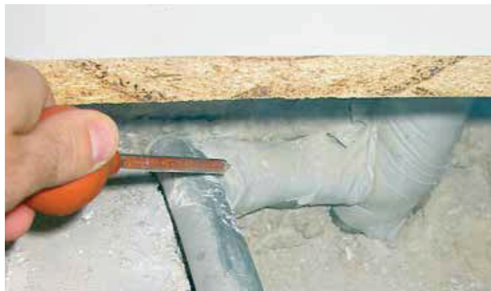
Figura 2.4: Esempio di zona d'installazione sporca, attraverso la quale l'aria dovuta a perdite viene trasferita da un appartamento all'altro. (Fonte: Scuola Universitaria Professionale di Lucerna – Hochschule Luzern)
