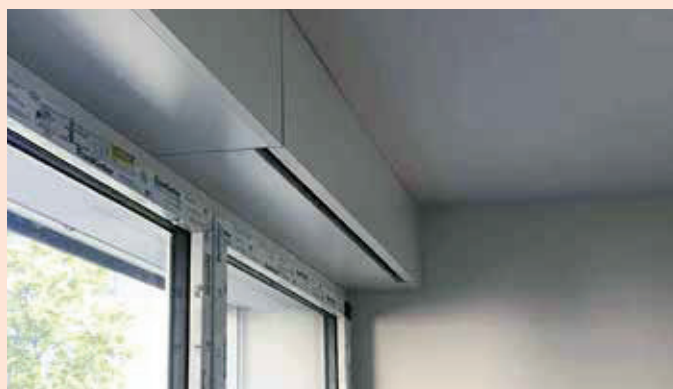
Figura 3.16: Gli apparecchi di ventilazione per singolo locale sono stati collocati negli allargamenti del telaio delle finestre senza particolari problemi. (Fonte: Ventoswiss AG)
