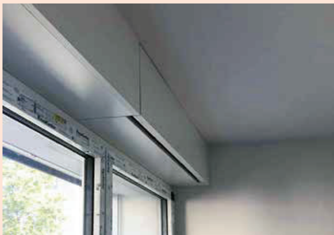
Bild 3.16: Die Einzelraumlüftungsgeräte liessen sich ohne grösseren Aufwand in den Rahmenverbreiterungen der Fenster unterbringen. (Quelle: Ventoswiss AG)
