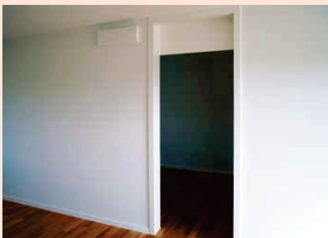
Bild 3.8: Der Verbundlüfter links oberhalb der Tür fördert Luft aus dem Wohnzimmer ins Schlafzimmer.
